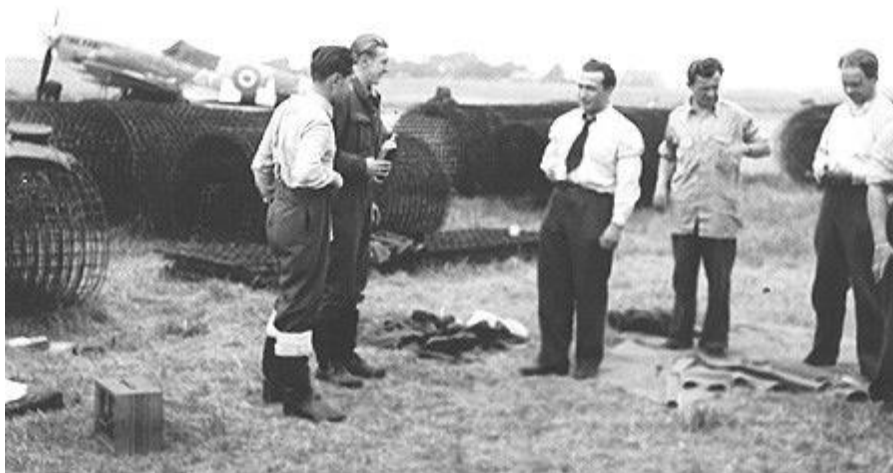
Pose des treillis métalliques.
