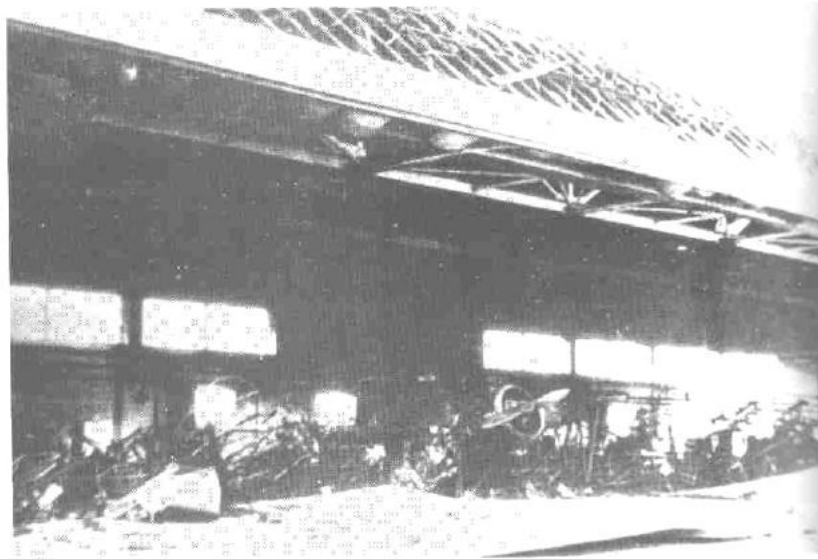
No. A/2. Zbombardowany hangar na drugiej grupie, 1 września 1939 w Krośnie. A bombed hangar at the second group (of buildings) in Krosno, 1st September
